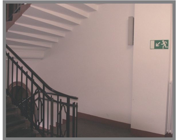
Fluchtwegmarkierung lang nachleuchtend
